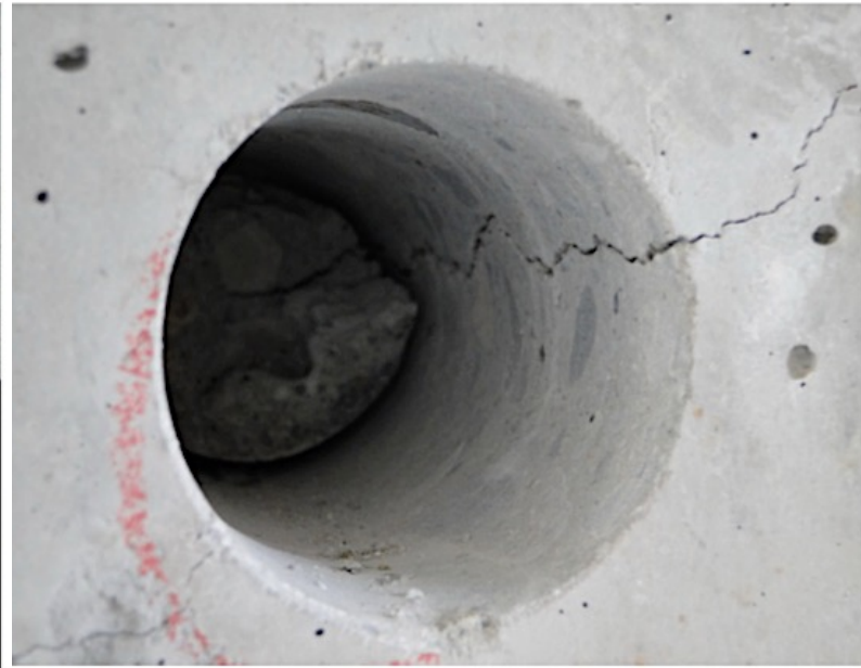
Photo 4 – Fissure pénétrant profondément dans le béton (mur nord)
