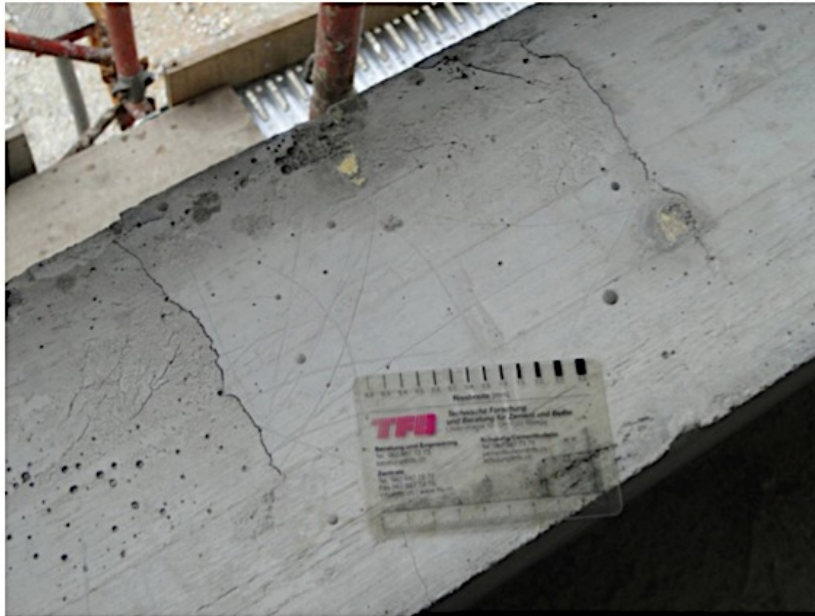
Photo 3 – Contrecoeur de fenêtre fissuré (sud)
